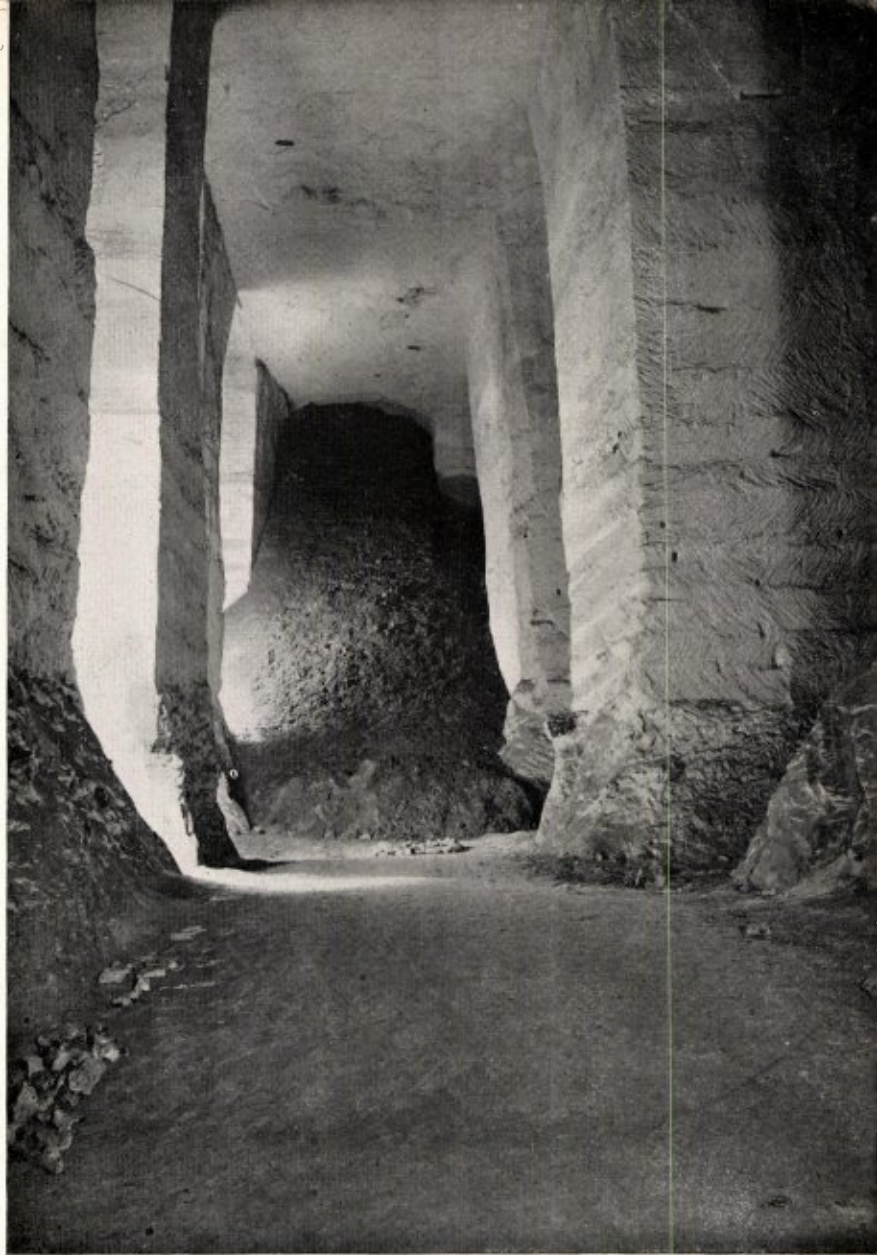
GANG IN HET ZUIDELIJK STELSEL VAN DEN ST. PIETERSBERG MET SCHUIN AFGEWERKTE KOLOMVOETEN EN DAARDOOR VERSMALDEN VLOER.
